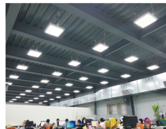
廠辦大樓 安裝燈具 120W 高度 7.5M 照度平均 600Lux
