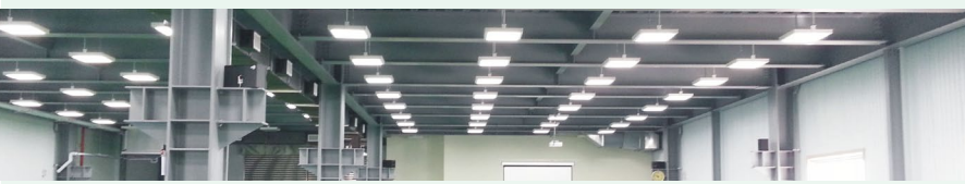
挑高建築設計 High Ceiling
