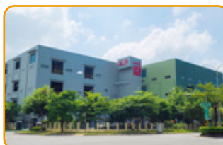
高雄本洲廠 Kaohsiung Ben-Chou Plant
