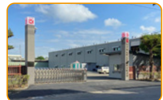
中壢自強廠 Chung-Li Plant 4
