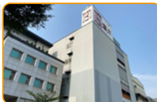
中壢三廠 Chung-Li Plant 3
